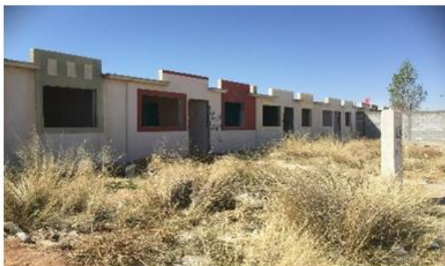
Figura 10 Exterior de las viviendas en el fraccionamiento Las Haciendas que muestran abandono y descuido. Fuente propia, tomada el 23 de marzo 2016
