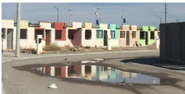
Figura 2: Abandono y contaminación del entorno en el fraccionamiento Las Haciendas al suroriente Ciudad Juárez. Fuente: propia, tomada el 21 marzo 2016.
